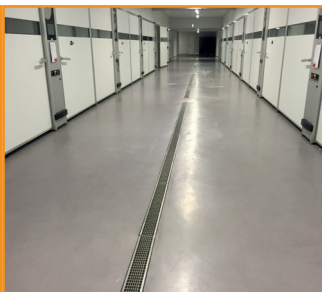
Nortura Samvirkekylling: Areal 1000 m 2 (behandlet med akrylbelegg)
