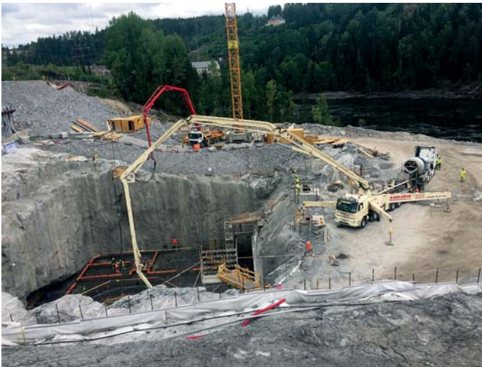
SKYTTELTRAFIKK. 9-11 betongbiler gikk i skytteltrafikk og det ble benyttet to betongpumper og tårnkran. Foto: AF Gruppen
